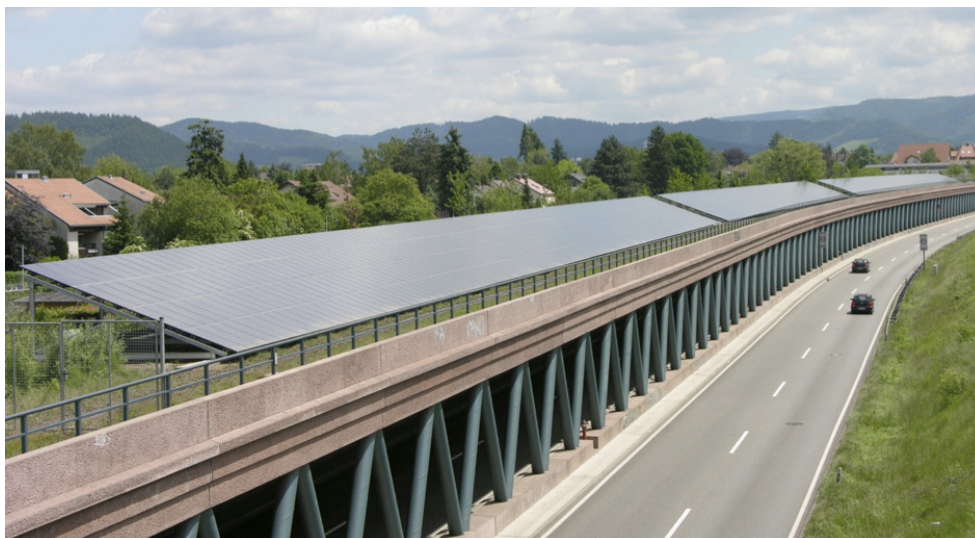
Należący do lokalnej społeczności system PV zainstalowany na ekranach akustycznych we Freiburgu w Niemczech. Źródło: fesa GmbH 2006
