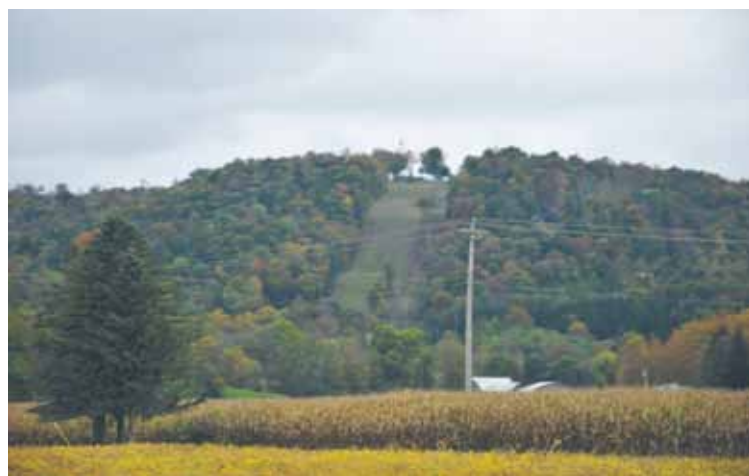
To nie trasa narciarska, tylko przecinka pod gazociąg. Na górze można dostrzec odwiert, na dole dach domu.
